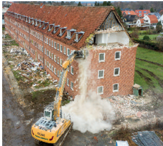
Abriss von Wohnungen mit niedrigen Mieten unter Einsatz von Förderdarlehen und Zuschüssen
