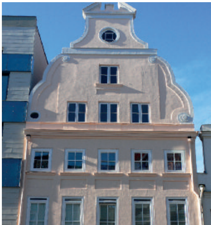
Das Vereinshaus in der Mühlenstraße 28. Der erste dokumentierte Besitzerwechsel dieses Hauses stammt aus dem Jahr 1291, der Mieterverein erwarb es 1931
